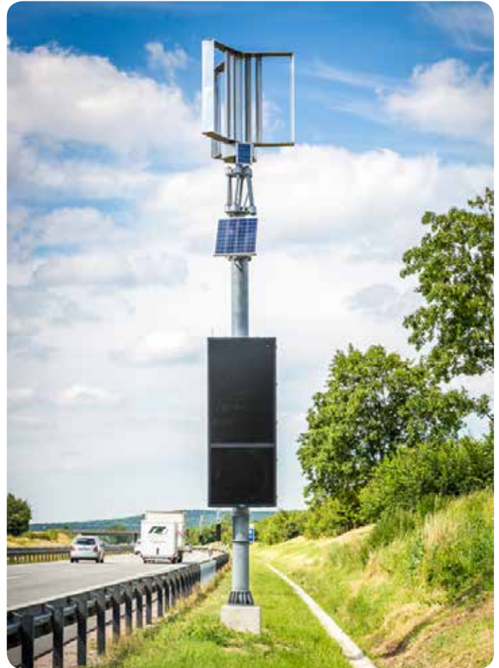
Vertikal-Klein-Windkraft-Anlagen / (Vertikalachsläufer) - H-Rotor
