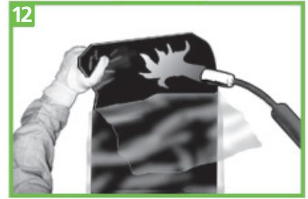
Ecken der Manschette einseitig ca. 20 x 50 mm abschneiden für spätere Unterlappung. Trennfolie ca. 15 cm vom Ende der Schrumpfmanschette (Unterlappung) abziehen und den Schmelzkleber mit der Propanflamme kurz anwärmen.
