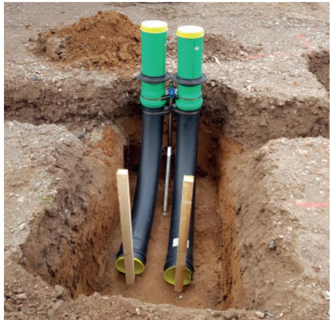
Im Bauherren Komplettpaket ist die passende 4 pipes Dichtung gleich mit enthalten: **Pressio®-Ringraumdichtung Typ FW** mit Großflansch für FW-Leitungen.
