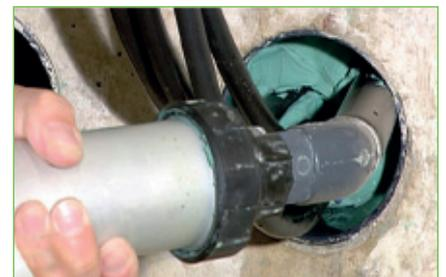
5. **Hohlraumfreies Ausfüllen** der Maueröffnung bis auf eine **Resttiefe von 50 mm**. Beginn der Füllung immer auf der Aussenseite, dann im Prozess des Füllvorganges die Spritzpistole immer weiter zurück nehmen.
