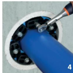
5. Nach ca. 2 Stunden die Schrauben nochmals mit dem angegebenen Drehmoment **nachziehen**. Abhängig von den äußeren Bedingungen (Temperaturen <10°C, großer Ringraum, usw.) diesen Vorgang mehrmals wiederholen. Dies ist besonders ab IL 500 und größer zu beachten.
