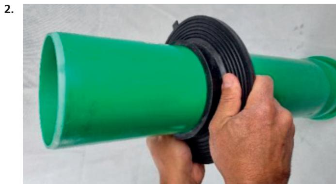
Mauerkragen auf Mediumrohr aufstecken und Mauerkragen mittig der Mauer bzw. Bodenplatte positionieren.
