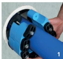
1. Die Enden der Pressio®-Elements **verbinden** und die **Druckplatten ausrichten**. Die Schraubenköpfe müssen alle in die Richtung des Monteurs zeigen.
