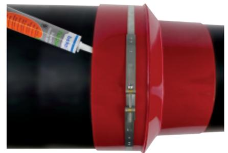
3. Rundum die Dichtmasse unter die Manschette auf dem Schutzrohr befestigen
