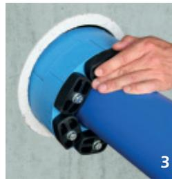
4. Die Schrauben auf 12 Uhr beginnend mit einem **Drehmoment-schlüssel anziehen**. Kein Anziehen mit Schlagschrauben! Jede Schraube mit ca. 4 bis 5 Umdrehungen anziehen. Diesen Vorgang **im Uhrzeigersinn** so lange wiederholen, bis das angegebene Drehmoment (siehe Tabelle) erreicht ist und der Gummi sich gleichmäßig zwischen den Druckplatten hervor wölbt.
