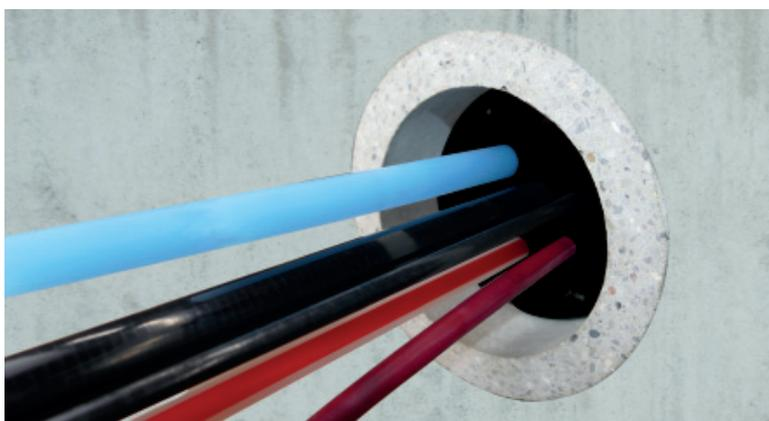
1. Futterrohr/Kernbohrung und Mediumrohre / Kabel reinigen.
