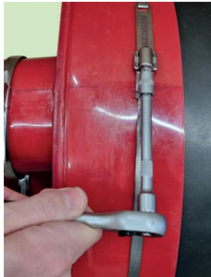
4. Die Manschette mit den Spannbänder am Schutz- und Medienrohren befestigen
