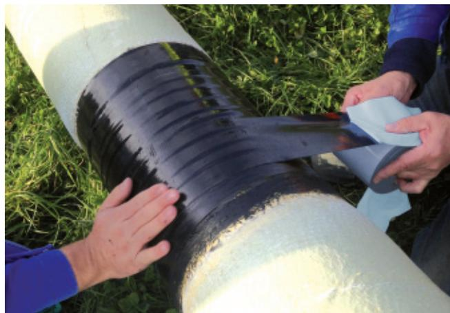
Flexibles Zweibandsystem für die Korrosionsschutzbeschichtung von Metallrohren, Pipelines, Behältern und Formteilen gemäß DIN 30672, EN 12068. Für **hohe Korrosionsschutz Anforderungen und mechanische Belastungen** bei unebenen Untergründen.
