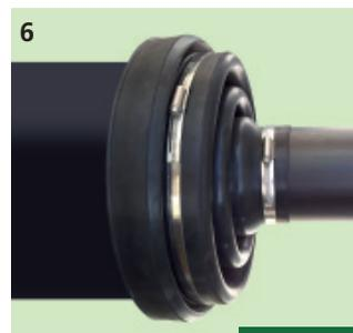
6. Die Manschette mit den Spannbändern am Medium- und Schutzrohr befestigen.
