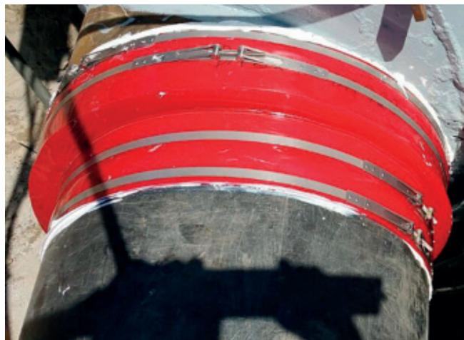
**Rohrbewegungen und -setzungen** sind die großen Herausforderungen für eine **Mauerdurchführung**, speziell an **gedämmten warmgehenden Rohrleitungen**.
