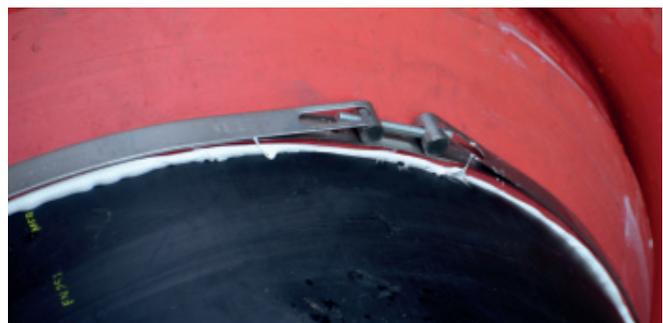
4 pipes Gelenkbolzenband ab **DA 315 mm**
