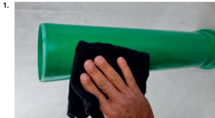
Einzubetonierende Rohroberfläche reinigen.
