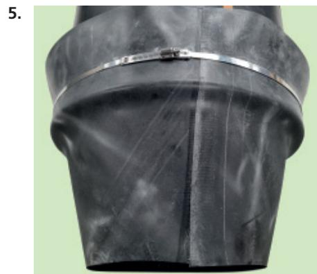
Das große Ende der Manschette wird auf das Schutzrohr gezogen bis sie stramm sitzt und mit dem Edelstahlspannband befestigt.
