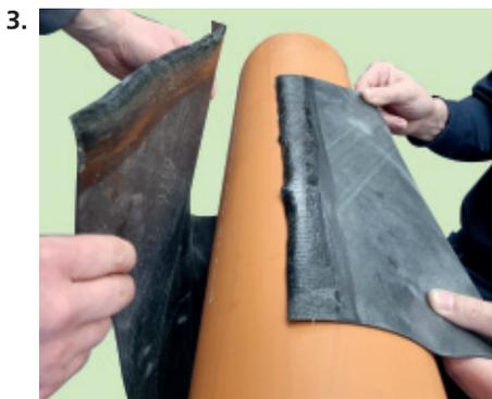
Nach dem Antrocknen der Klebeflächen wird die AKO-Manschette um das Mediumrohr gelegt.
