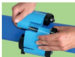
2. Es kann sein, dass die Kette leicht durchhängt. **Es dürfen keine Elemente aus der Kette genommen werden**. Es muss die angegebene Anzahl an Elementen eingebaut werden. Es kann erforderlich sein, dass die Kette bei kleineren Rohrdurchmessern leicht gedehnt werden muss.
