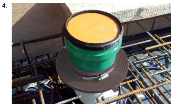
Der 4 pipes Mauerkragen kann nun in der Mauer oder Bodenplatte vergossen werden.
