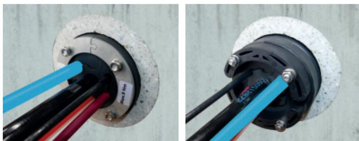
6. Ringraumdichtung in das Futterrohr bzw. die Kernbohrung einfügen.
