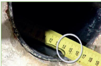
3. **Schaumband oder -stopfen** 150 mm tief in die Wandöffnung schieben. So wird eine Sperre nach außen für die Dichtmasse gebildet - möglichst auch zwischen den Leitungen.
