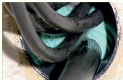
4. Kabel und Rohre möglichst auseinander biegen, so dass die **Masse zwischen die Leitungen** gespritzt werden kann.
