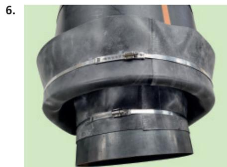
Anschließend wird die Manschette eingestülpt und am Mediumrohr mit dem Edelstahlspannband befestigt.
