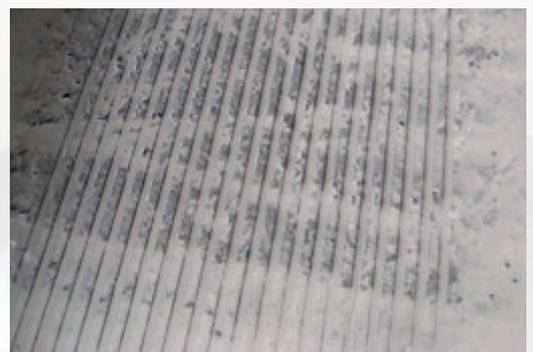
Rillenprofil in einer Betonfläche
