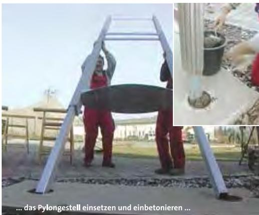
... das Pylongestell einsetzen und einbetonieren ...
